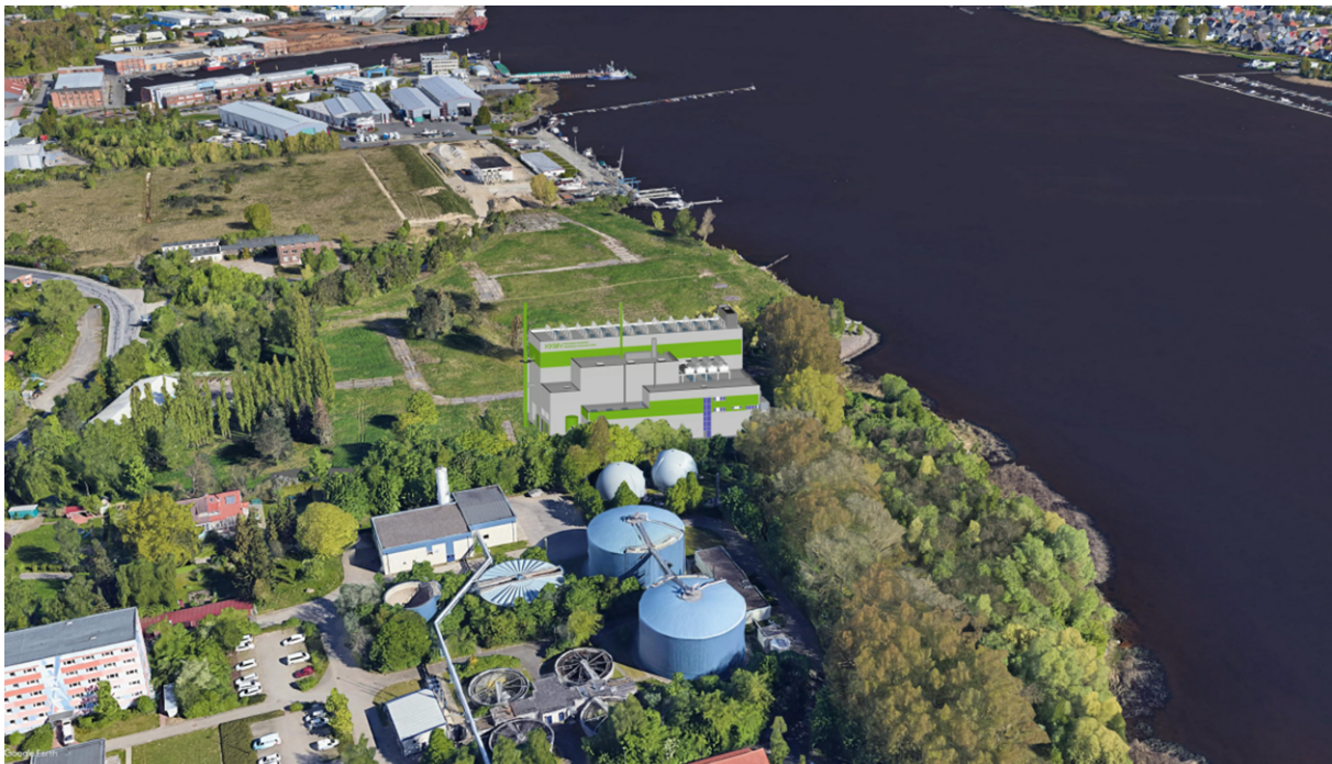
Abbildung 3: Standort der Verwertungsanlage in Rostock
